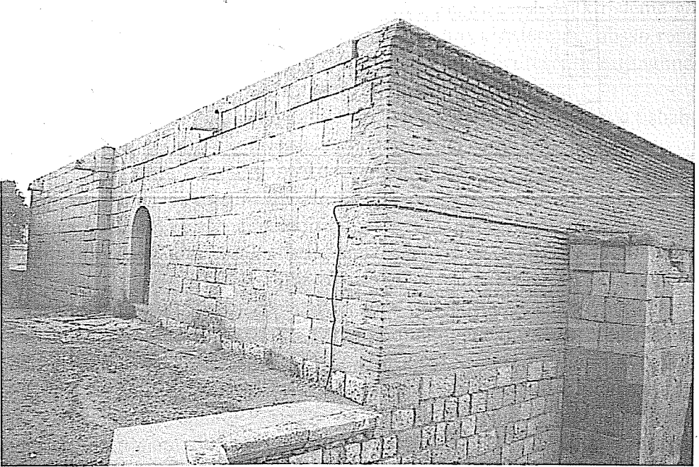
Fotoğraf 26: Afşin Eshab-ı Kehf Medresesi, güneybatı taraftan görünüş.
